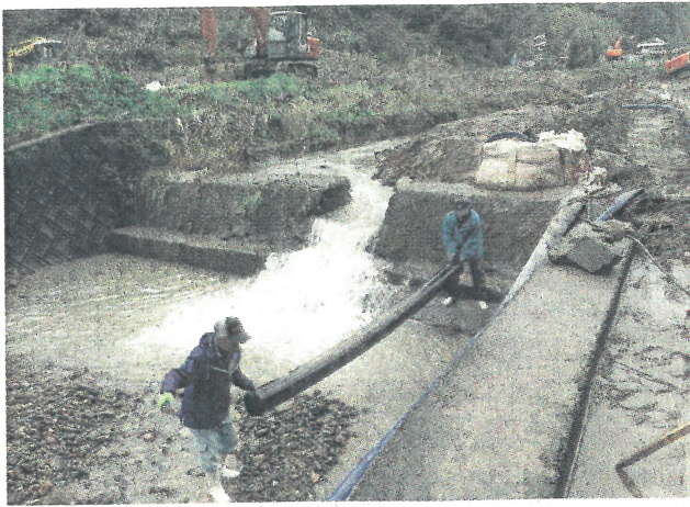
被災箇所の応急措置
